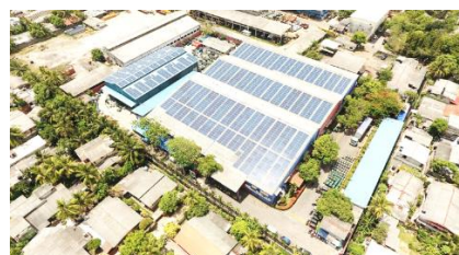
(Rooftop Solar System)
